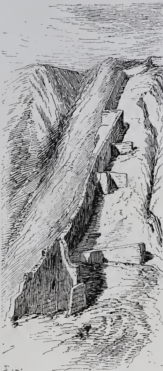
Mur de défense (forteresse de Ollantaïtambo) en schistes ardoisiers recouverts de stuc. (Page 556.)
