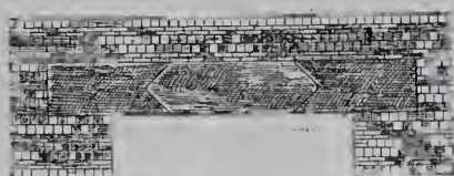
Linteau, en trois briques séchées au soleil, d'une porte de la façade nord du même palais.
