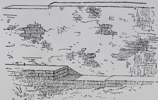
Mur en pisé à Paramonga.
