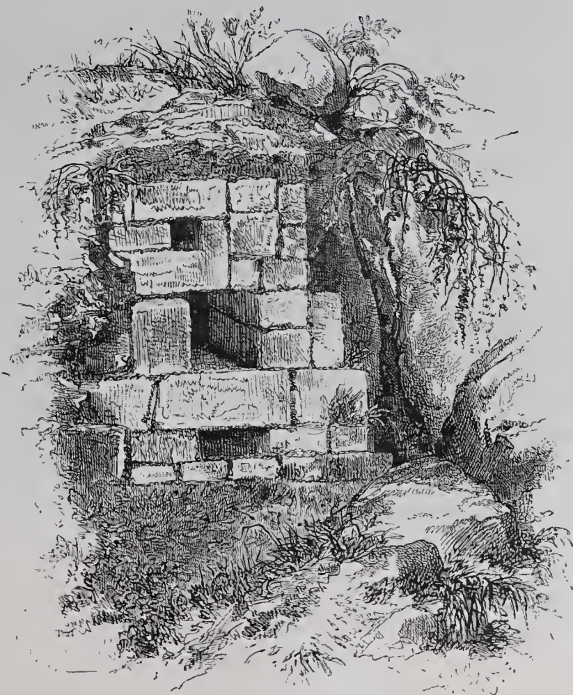
Canaux souterrains du mont Sipá.
